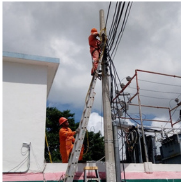
Trabajos en altura
