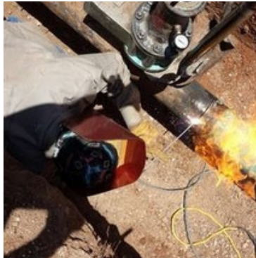
Soldadura (MIG, MAG Y TIG)
