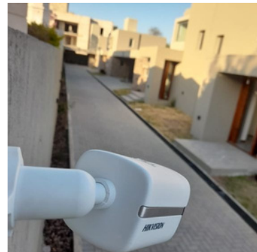
Instalación de cámaras de seguridad
