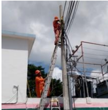
Trabajos en altura
